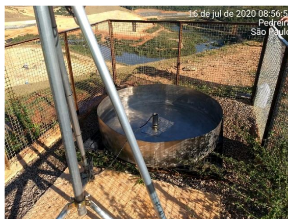
Foto 6 – Estação meteorológica após o procedimento de manutenção. (Data:16/07/2020).
