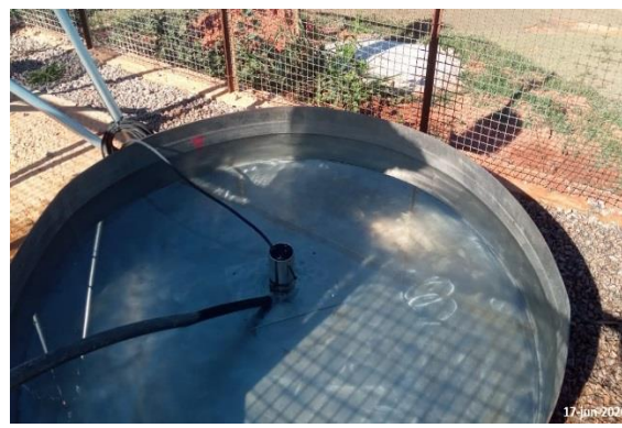
Foto 4 – Limpeza do tanque do reservatório. (Data: 17/06/2020).
