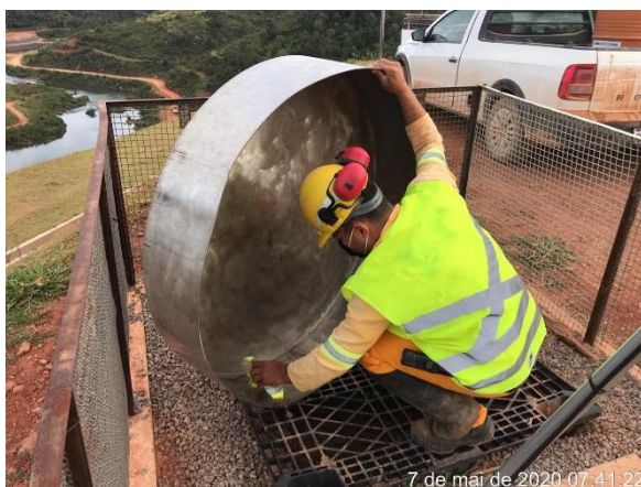
Foto 1 – Processo de manutenção da estação meteorológica. (07/05/2020).
