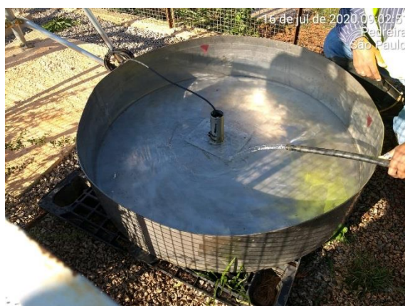
Foto 5 – Detalhe da manutenção da estação. (Data:16/07/2020).
