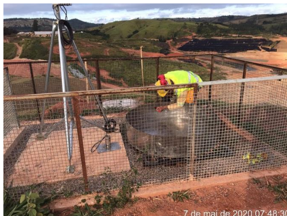
Foto 2 – Marcação de nível no tanque do reservatório. (07/05/2020).
