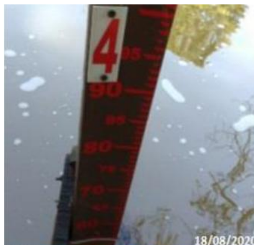
Foto 16 – Detalhe das réguas limnimétricas após a manutenção no PHM - 12°C (Data: 18/08/20).
