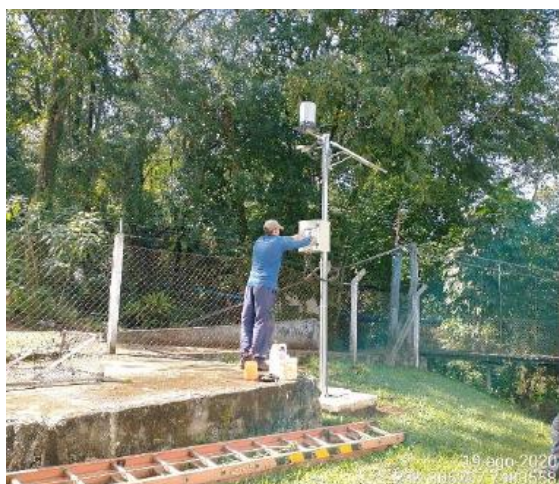
Foto 15 – Vista do trabalho de manutenção da estação do PHJ limpa - 11°C (Data: 19/08/20).
