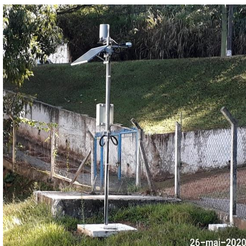
Foto 9 – Vista da estação telemétrica no PHJ – 8ª Campanha (Data: 26/05/2020).
